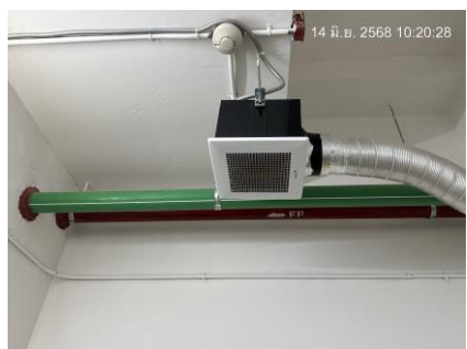
พัดลมดูดอากาศภายในห้องพักมูลฝอย
