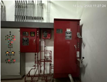
ระบบสูบน้ำดับเพลิง
